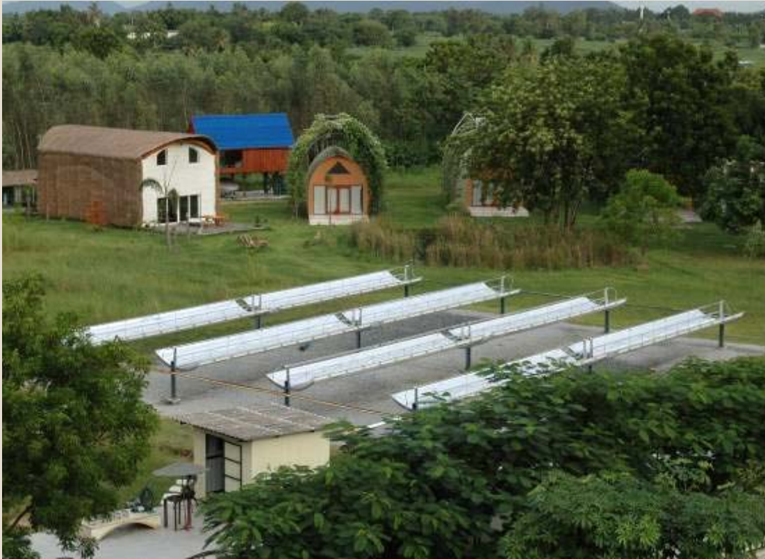
Erstes solarthermisches Kraftwerk in Thailand mit 100 kW therm.
